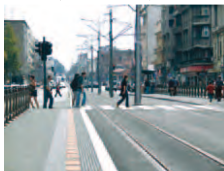
Slika 3: Rekonstruisani tramvajski koridor u Bulevaru kralja Aleksandra
