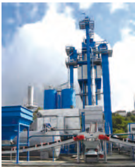
Asfaltna baza BENNINGHOVEN 240t/h -JKP „Beograd - put“
