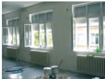
Slika 8: Izgled adaptirane prostorije u okviru Stare upravne zgrade
